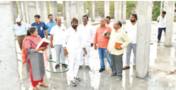
మార్కెట్ నిర్మాణ పనులు పరిశీలిస్తున్న మంత్రి శ్రీనివాస్ గౌడ్
